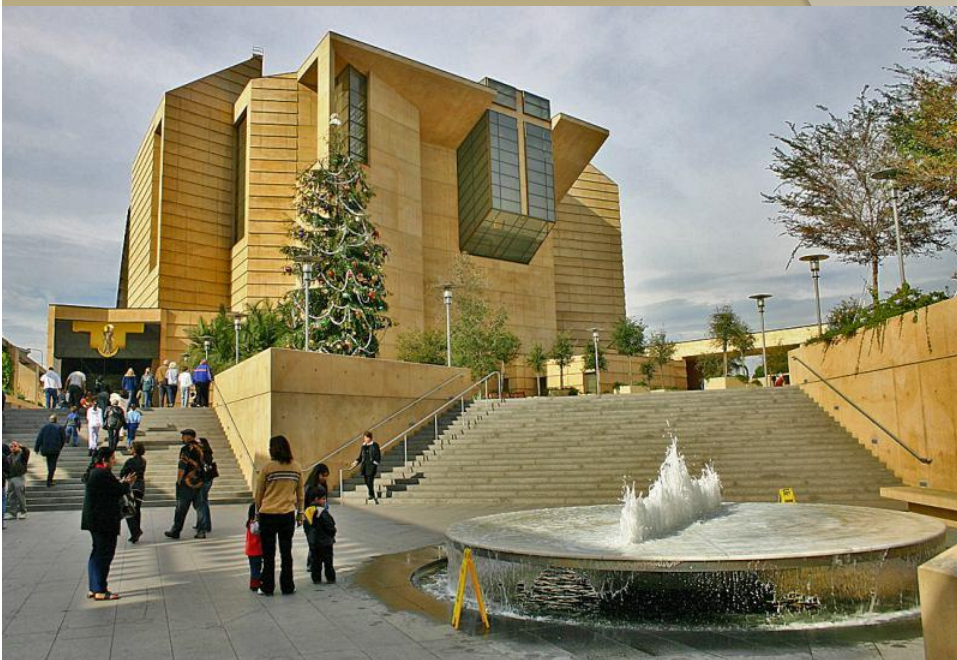
FOTO DE UNA CATEDRAL EN LOS ANGELES CALIFORNIA, EN LA QUE SE UTILIZO EL AISLAMIENTO DE LA BASE
